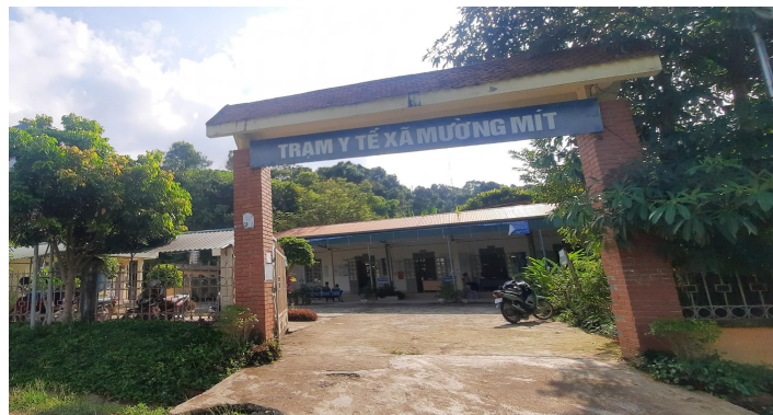
Trạm y tế xã Mường Mít
