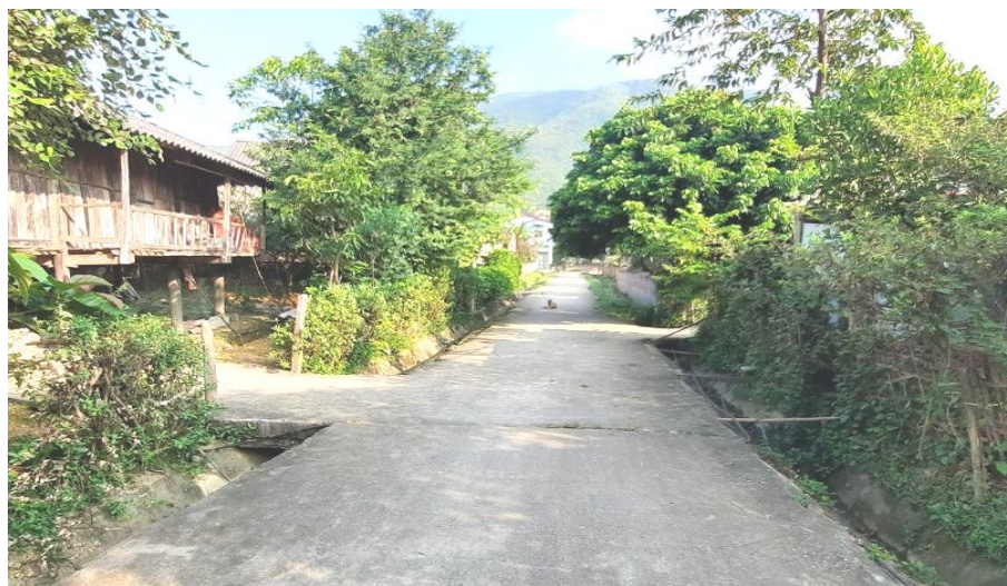
Hình 02: Đường liên xã, đường trục thôn bản, đường nội bản của xã Mường Mít đã được cứng hóa
