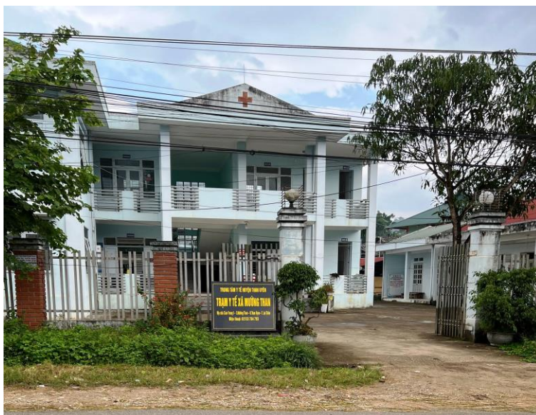
Trạm y tế xã Mường Than
