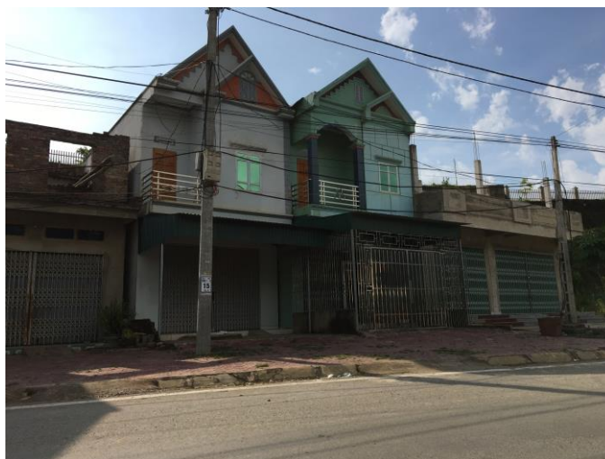
Nhà ở kiên cố dọc trục đường Quốc lộ 32
