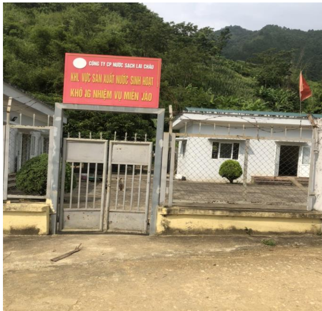
Trạm nước sạch xã Hua Nà
