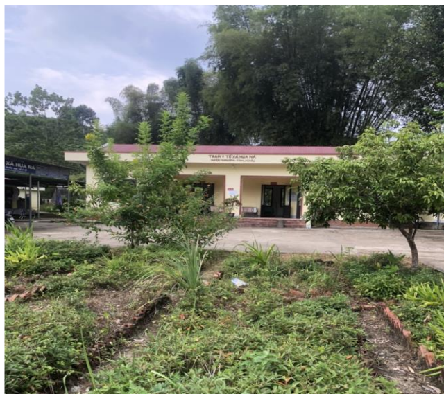
Trạm y tế xã Hua Nà
